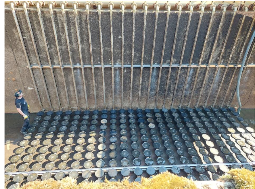
Puhdistamon biovaihe 2 ilmastus, ilmaputkiston saneeraus
