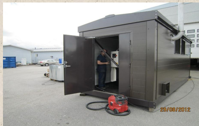
Puhdistamolle hankittu varavoimakone tehdastestissä
