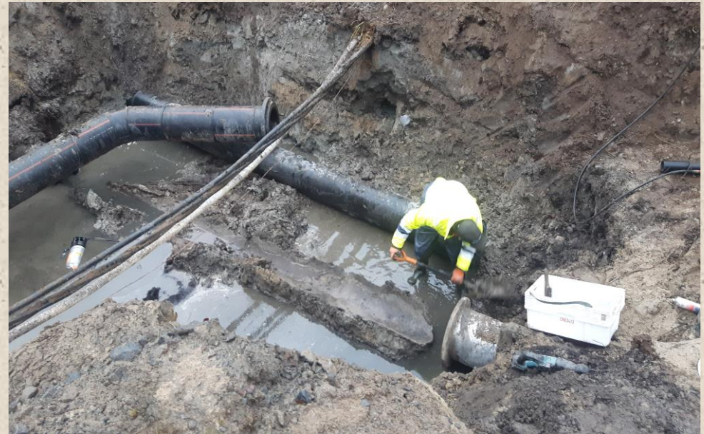
Uusi 400 PEH paineviemäri liitettiin Nahkatehtaan pumppaamon teräksiseen paineputkeen 9.11.2018.
