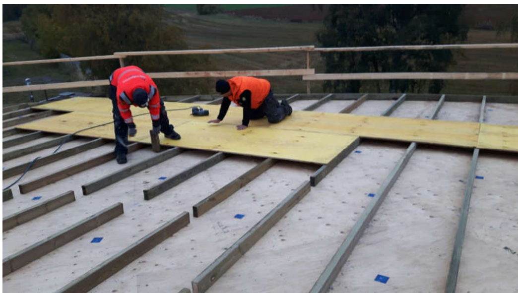
Rakennus 2 katon uusintaa haittasi epävakainen syksy, mutta valmista tuli joulukuussa. Saneeraustyö jatkui heti julkisivujen uusimisella.
