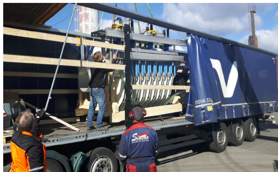
Jälkikäsittelyn kapasiteetin riittävyyden varmistamiseksi hankittiin kolmas Mecana kiekkosuodatin kahden 2013 ostetun rinnalle.
